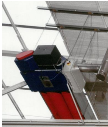
Générateur gaz sous toiture
