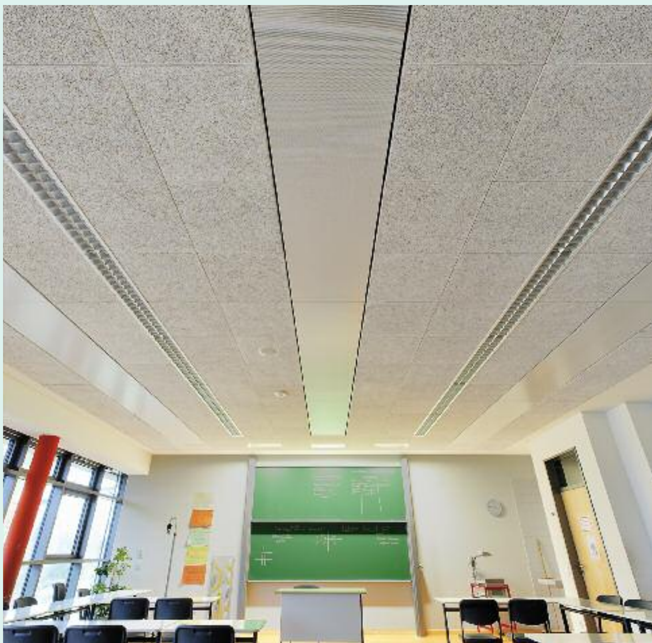
Exemple d'implantation : panneau rayonnant perforé intégré en faux-plafond
