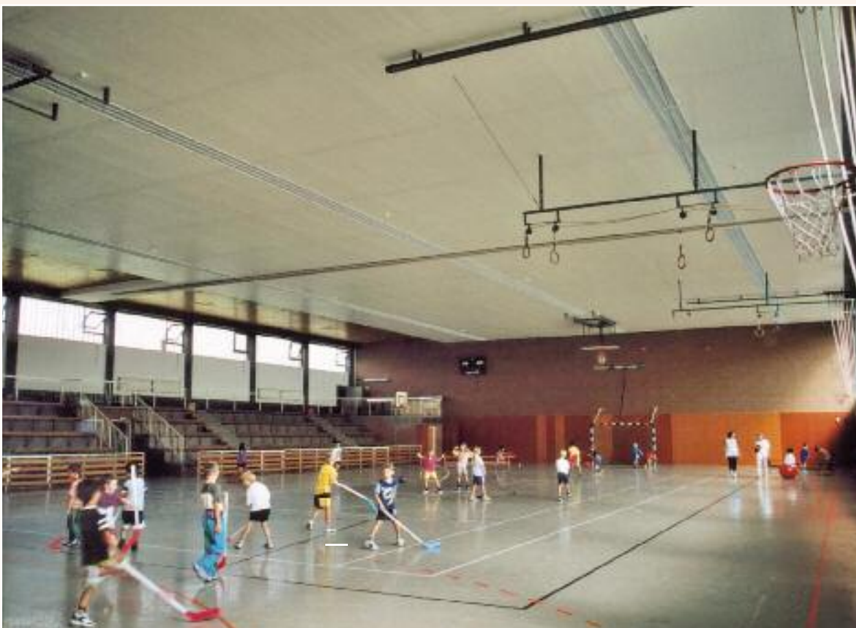
Panneaux HKE-CS : montage en plafond complet
