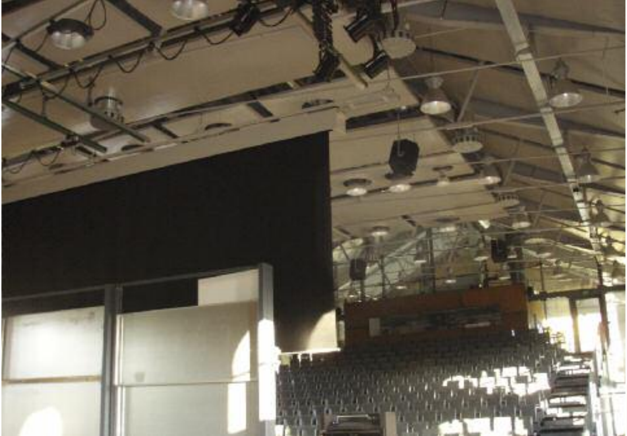
Panneaux HKE-CS suspendus sous toiture. Version perforé-phonique
