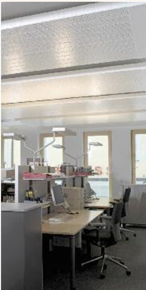
Panneaux HKE-CS sous plafond version perforé-phonique
