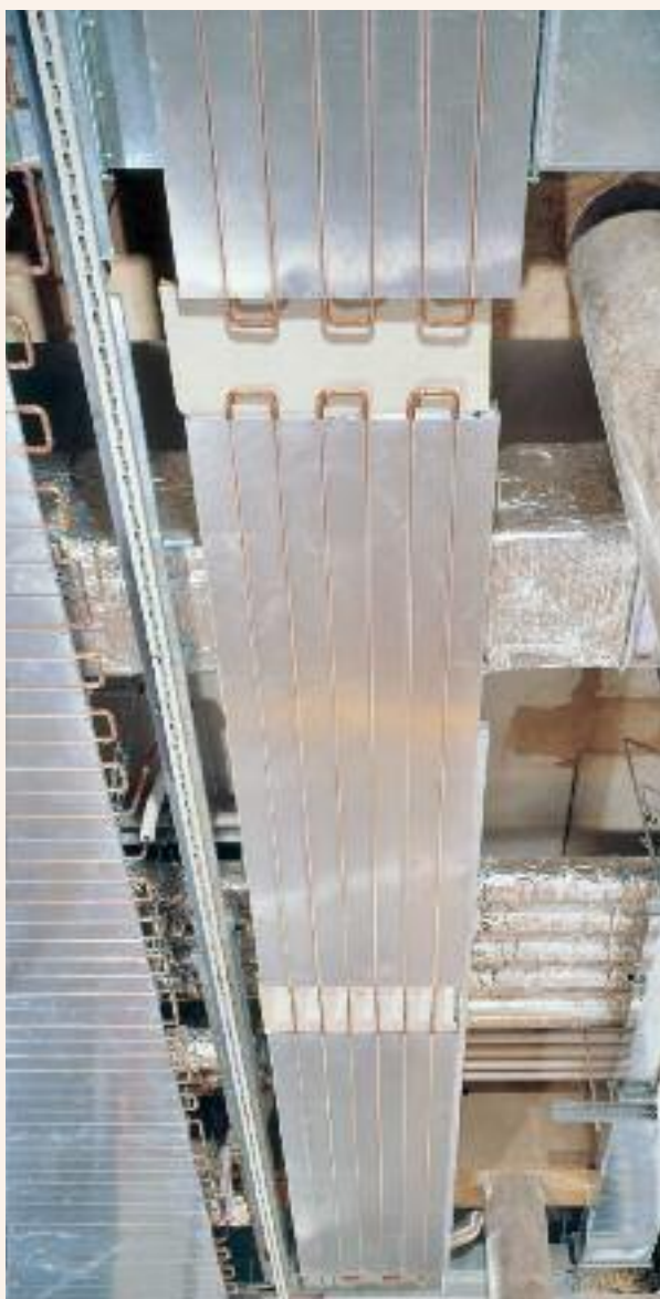
Panneau rayonnant Sstructure HKE-CS avant habillage.
